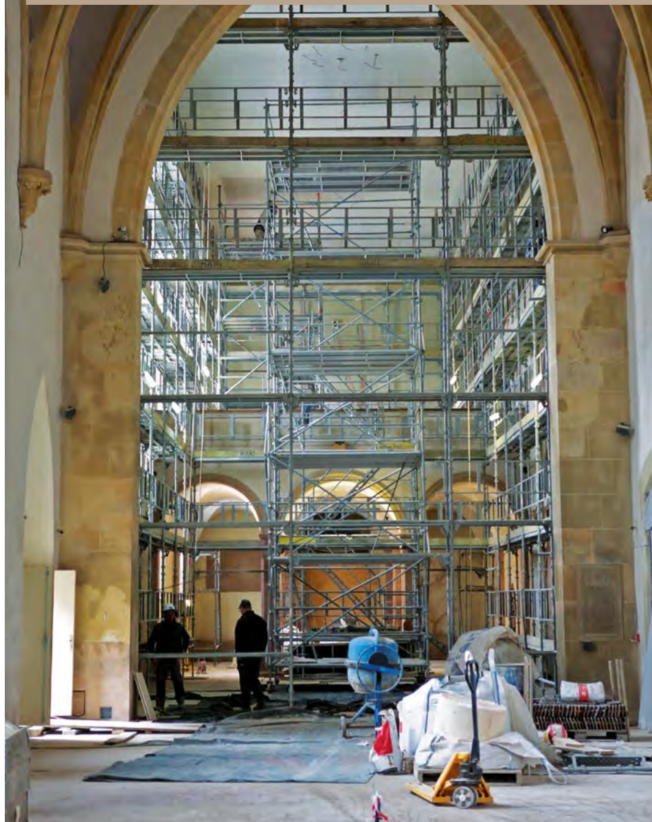
◀ Travaux dans la chapelle
